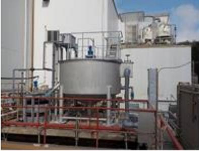
エコレルフローターは、排水中の油脂分及び浮遊物質を超微細気泡で浮上分離する、マイクロバブル発生装置です。
